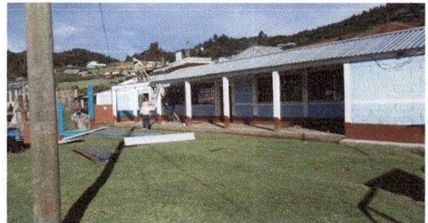
Foto 4: sustitucion de capote y elementos de fijacion
